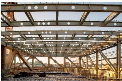
Das Stahlfachwerk bildet das neue Obergeschoss. Foto: Kollektiv Fischka
