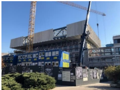
Baustelle Wien Museum Neu, Foto: Wien Museum
